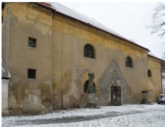
pohled na fasádu s otiskem předsíně
