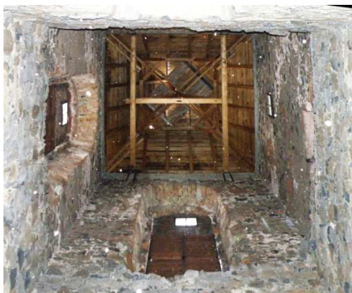
pohled do těla věže
