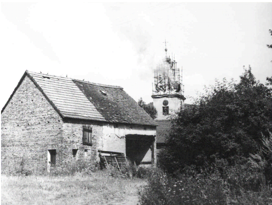
požár věže r. 1975 (foto p. Sahula)
