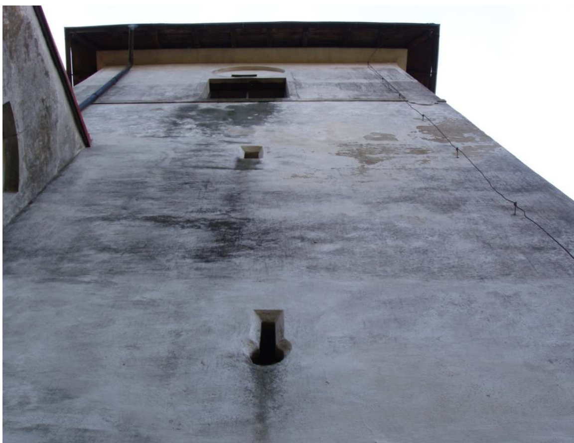
Monumentální hmota věže s gotickým jádrem
