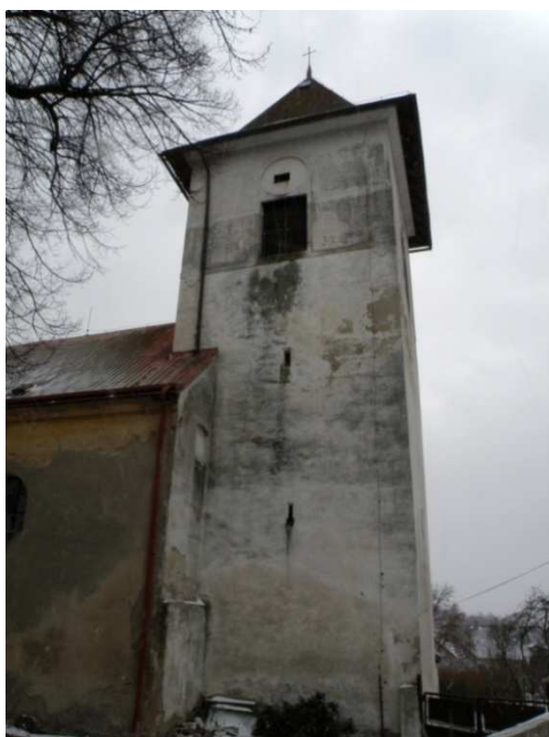
pohled na věž od hřbitova
