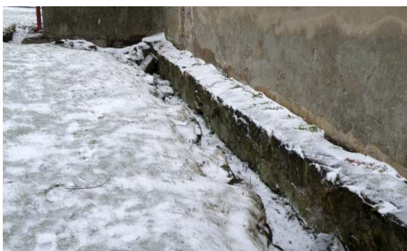
odvlhčovací žlab u lodě a zákristie
