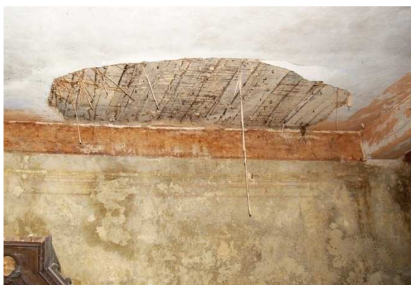
pohled kruchty s poškozením omítky
