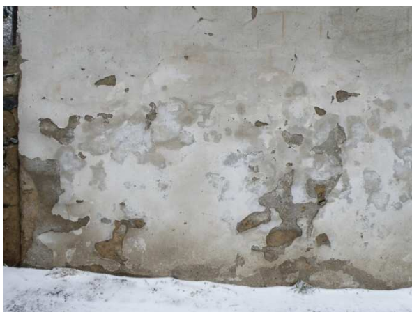
soklová parte u věže
