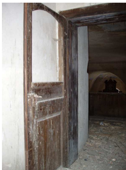
vstup ze schodiště na kruchtě
