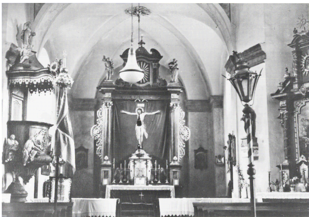
Interiér před r. 1945
