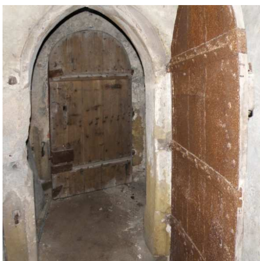
portál do věže
