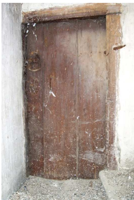
vstupní dveře do horní části věže
