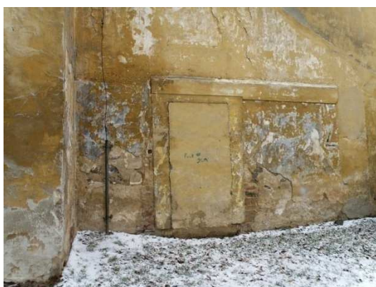
zazděné dveře do presbyteria
