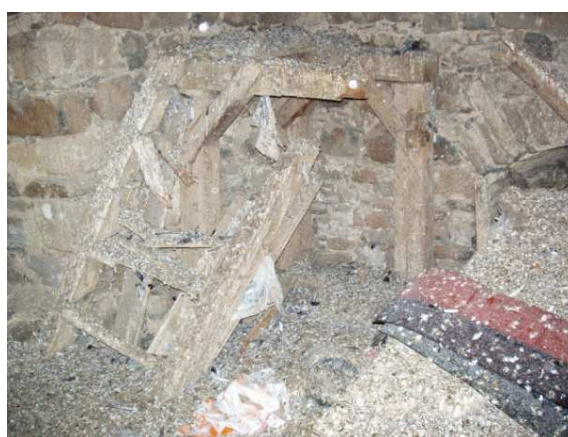
detail torza schodiště ve věži
