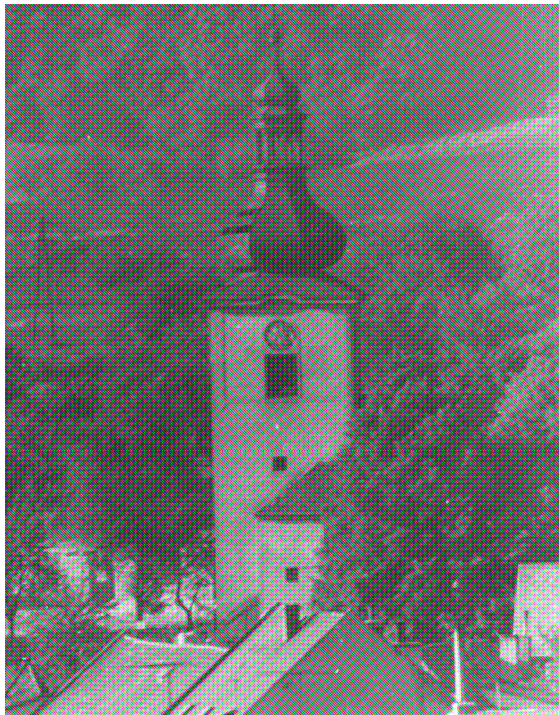
věž před požárem
