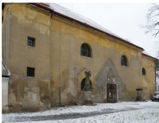
pohled na vstupní část do lodě
