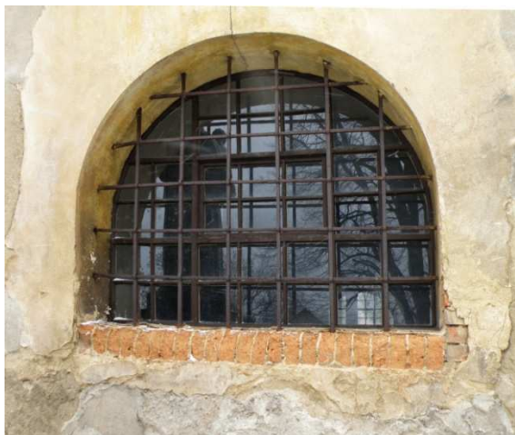
novodobé okno lodě s kovanou mříží
