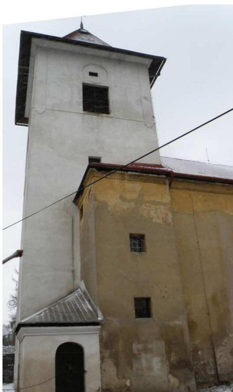
pohled na věž od vstupu
