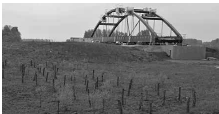
Inundační most v louce u Mohanu (29. 4. 2014, GPS: 50°6'20"N, 10°57'34"E, 257 m nad mořem)
