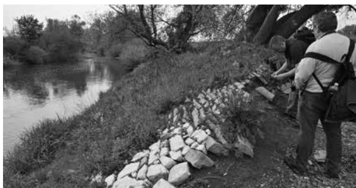
Likvidace původní břehové hráze Mohanu (29. 4. 2014, GPS: 50°6'20"N, 10°57'38"E, 245 m n. mořem)
