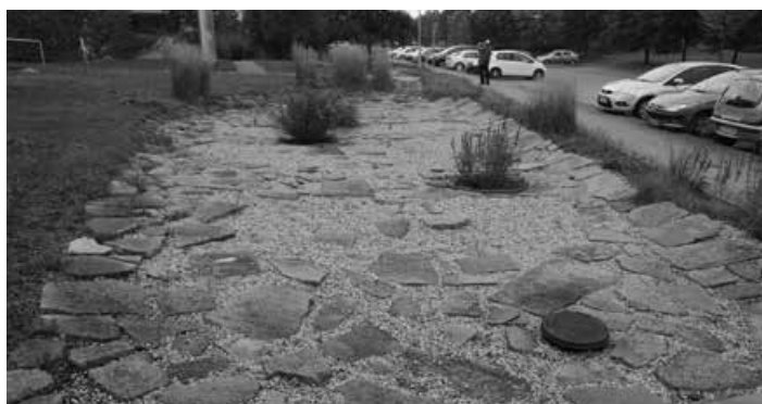
Vsakovací nádržka u rekonstruovaného paneláku v Drážďanech (8. 9. 2014, GPS: 51°2'50"N, 13°39'19"E, 216 m n. m.)
