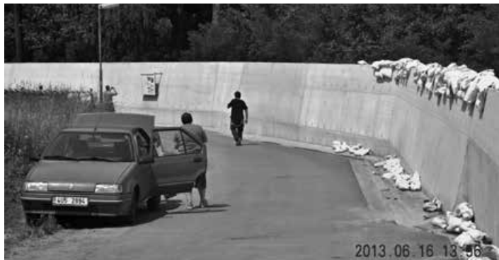
Hráz v Hoříně po povodni (16. 6. 2013, GPS: 50°20'29"N, 14°28'3"E, 178 metrů n. m.)
